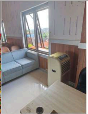
Kondisi pencahayaan, sirkulasi dan kelistrikan di aula
